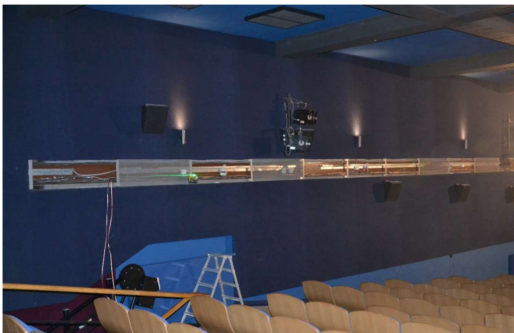
Výměna osvětlení v Kině Svratka
