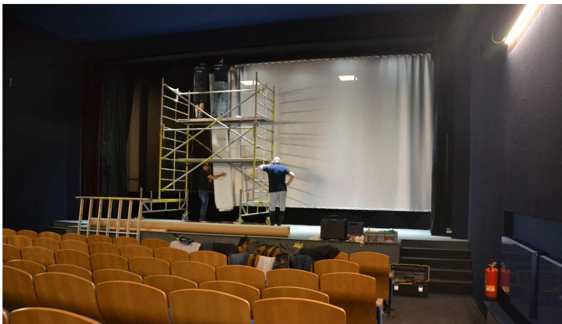
Výměna projekčního plátna v Kině Svratka
