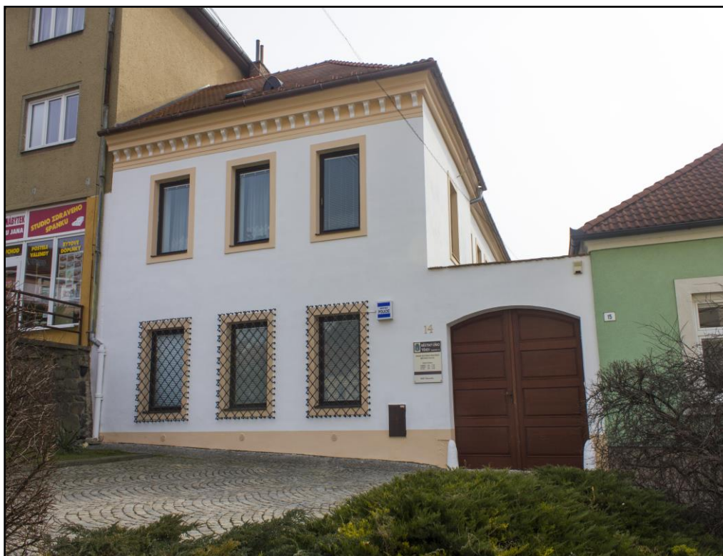
Foto 2 - Budova úřadu, Radniční 14
